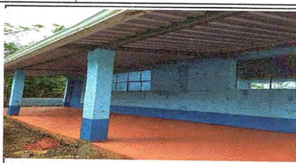
Foto 2: Estructura finalizada de las columnas de concreto.
