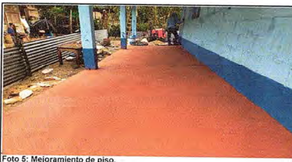
Foto 5: Mejoramiento de piso.
