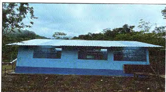
Foto 3: Colocación de ventanas de metal en las partes delantera y trasera de la escuela.
